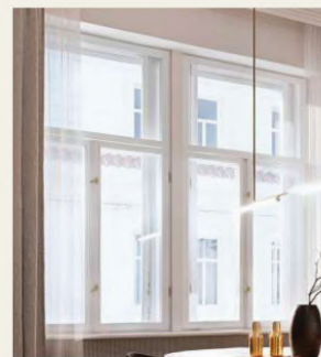
Repliky původních oken materiál dřevo, povrch dveří lak RAL 9013
